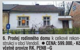
6. Prodej rodinného domu k celkové rekonstrukci v obci Vendolí. ● CENA: 599.000,- Kč včetně provize RK. PENB - G
